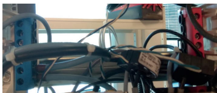
Figure 3: Borniers d'arrivée bleu, rouge et vert/jaune
