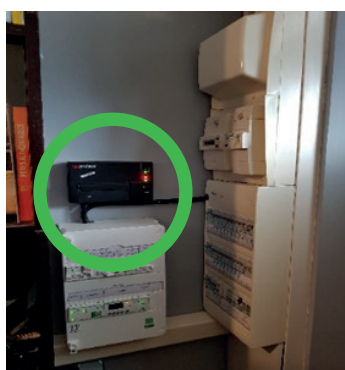
Figure 12: Câblage du boîtier ENPHASE aux borniers E N et E PH
