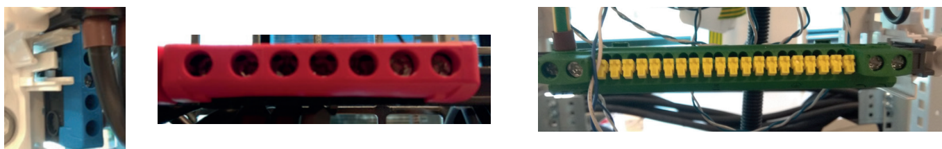
Figure 3: Borniers d'arrivée bleu, rouge et vert/jaune
