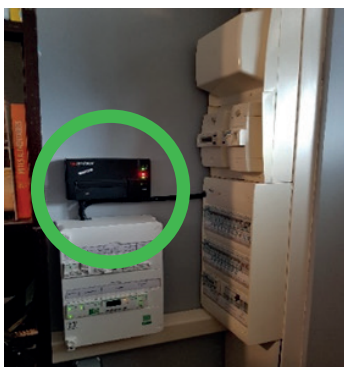
Figure 11: Câblage du boîtier ENPHASE aux borniers E N, PH1, PH2, PH3
