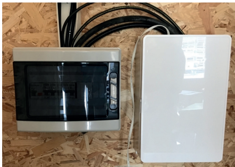
Figure 13: Fin du montage
