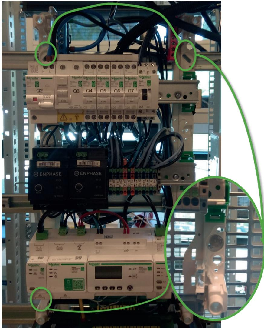
Figure 1: Montage du tableau sur le mur, positions des 4 vis
